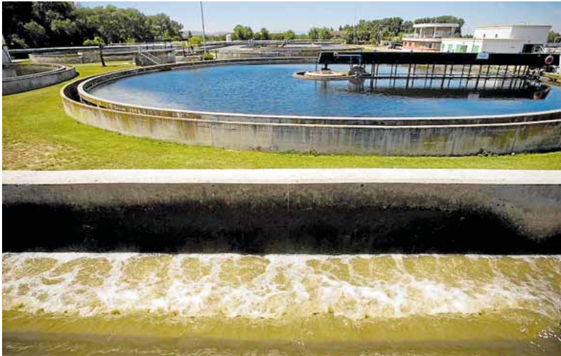
Estación depuradora de aguas residuales. ÓSCAR CHAMORRO
